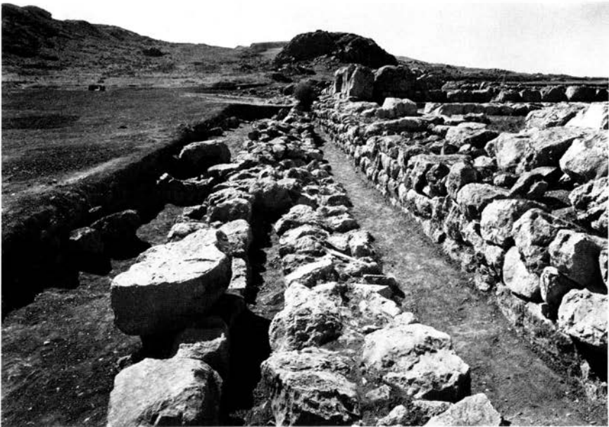
Abb. 3. Abwässerkanal vor den Südost-Magazinen des Großen Tempels
