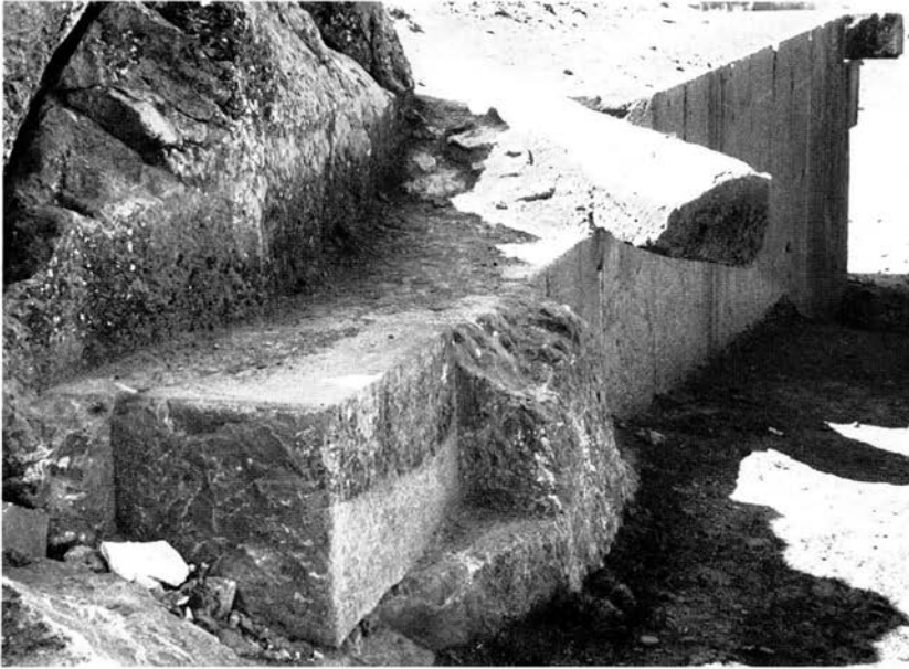
Abb. 6. Felsabtreppungen am östlichen Beginn der nördlichen Terrassenmauer
