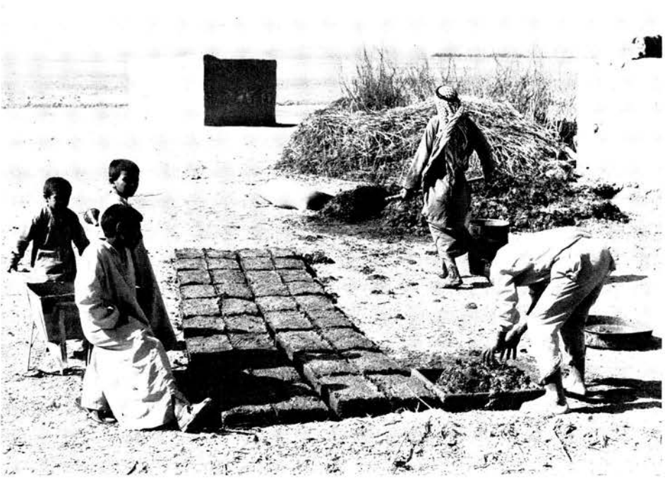
A. Das Herstellen der Lehmziegel aus Erde, Häcksel und Wasser mit der Holzform
