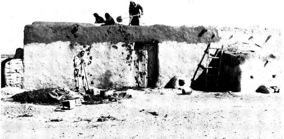
B. Dachdeckung mit stark häckselhaltigem Lehmmörtel
