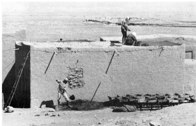
Abb. 3: Dachausbesserungen am Grabungshaus von Tall Munbāqa. Foto D.R. Frank.
