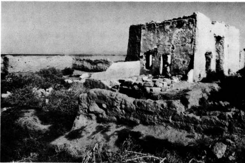
Abb. 3 Verlassenes Dorf im syrischen Euphrat-Stauseegebiet, etwa ein Jahr nach Abbau der Dächer und anderer Holzteile: an den Mauern ansetzende Schuttkegel nach einer Niederschlagsperiode (Photo: W. Bitterle).
