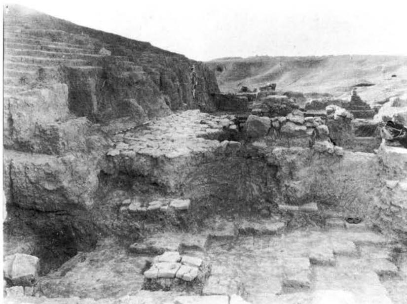
Abb. 16. Das abgetretene parthische Steinpflaster entlang der SW-Kante der Ziqqurrat. Dieses nimmt auf die Gliederung der Fassade Bezug. Darunter liegen die assyrischen Ziegelpflaster aus dem 1. Jahrtausend. Quadrant gD4V,5I, von Norden (Ass Ph.5772, WVDOG 67 [1955] Taf. 21a)
