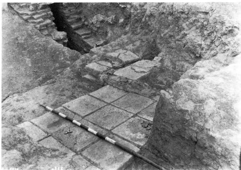
Abb. 12 Westliche Abortanlage (A II) mit dem Salmanassar I.-Pflaster, dahinter der Palastkanal. Quadrant gB5II, von Südosten (Ass Ph.5839)
