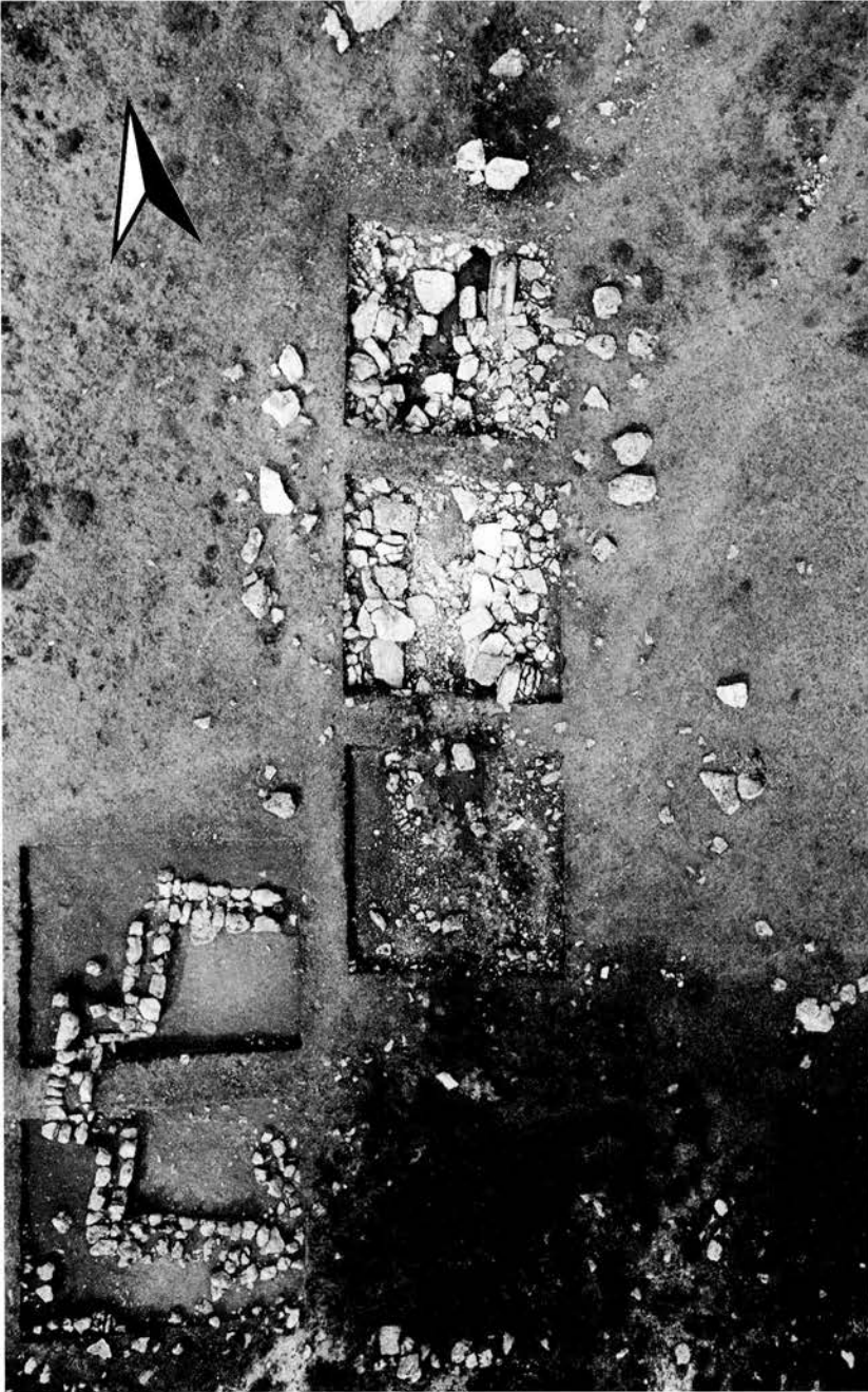
Abb. 24 Luftaufnahme des Ablaufkanals am Nordrand des Quellteiches. Stand der Arbeiten im September 1998.
