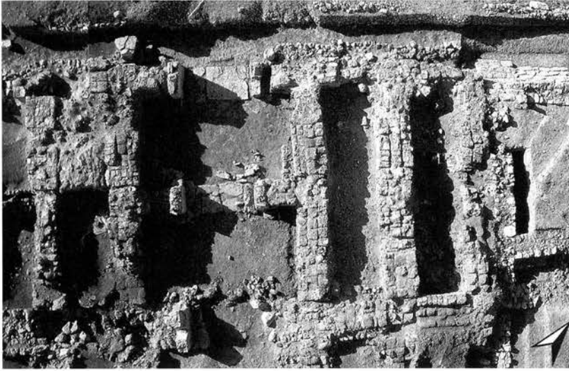
Abb. 13 Luftaufnahme des Südost-Tores von Kuşaklı. Stand der Arbeiten im September 1998.
