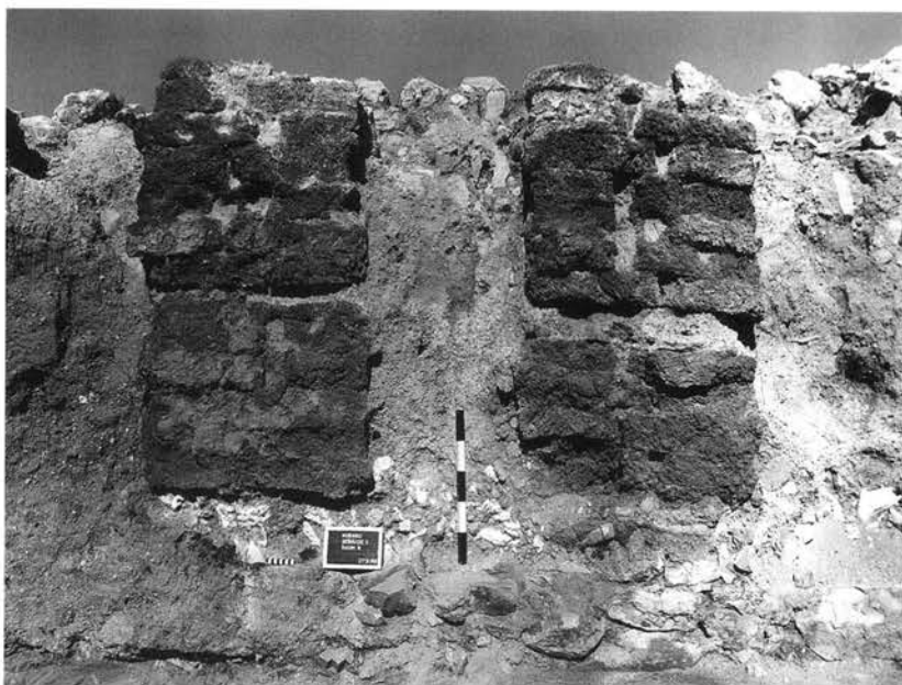
Abb. 7 Gebäude C, Nordwestwand des Raumes 8 mit senkrechten und waagrechten Balkenlücken sowie der Lehmziegelausfachung.
