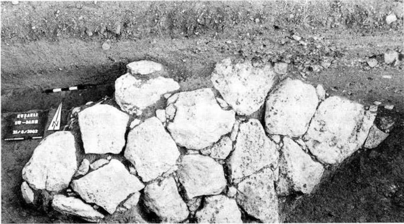
Abb. 11: Freigelegtes wasserseitiges Böschungspflaster des Staudammes vor dem Südwest-Tor von Kuşaklı.
