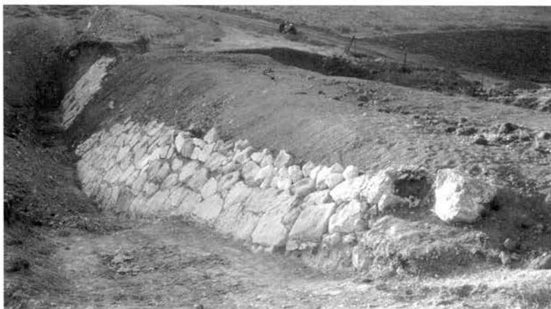
Abb. 8: Luftseitige Böschungspflasterung des Nordwest-Dammes von Kuşaklı.
