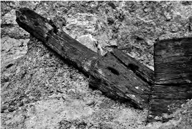
Abb. 40: Holzbalken mit Seilabdrücken.
