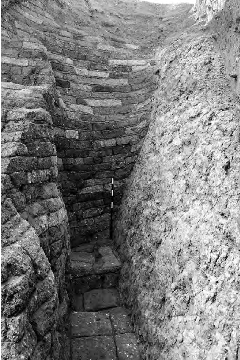
Abb. 26: Terrassenmauer (links) vor der Falaise und angrenzende Seitenwange des vorspringenden Fels-Glaciis (rechts); von Nord.
