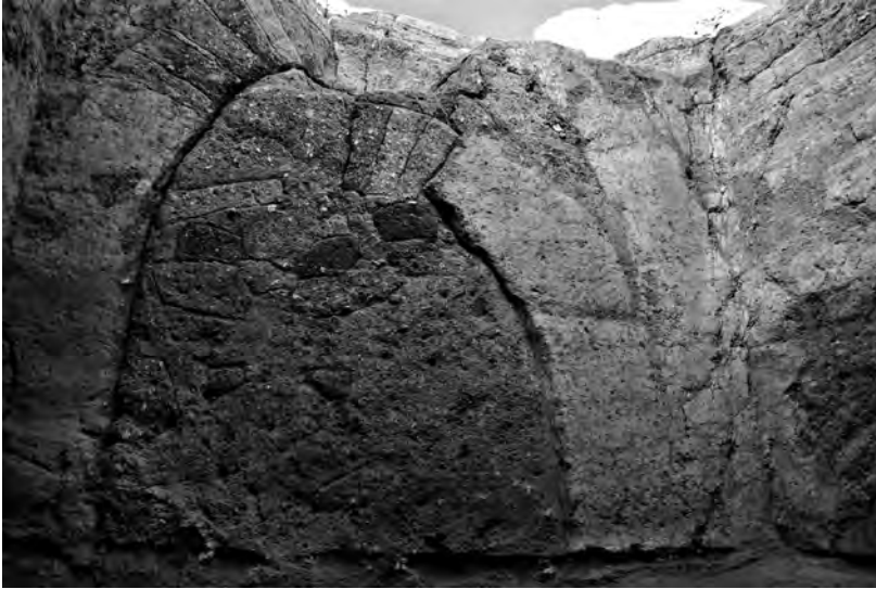
Abb. 5: Torbogen in der Westmauer von Raum EM.
