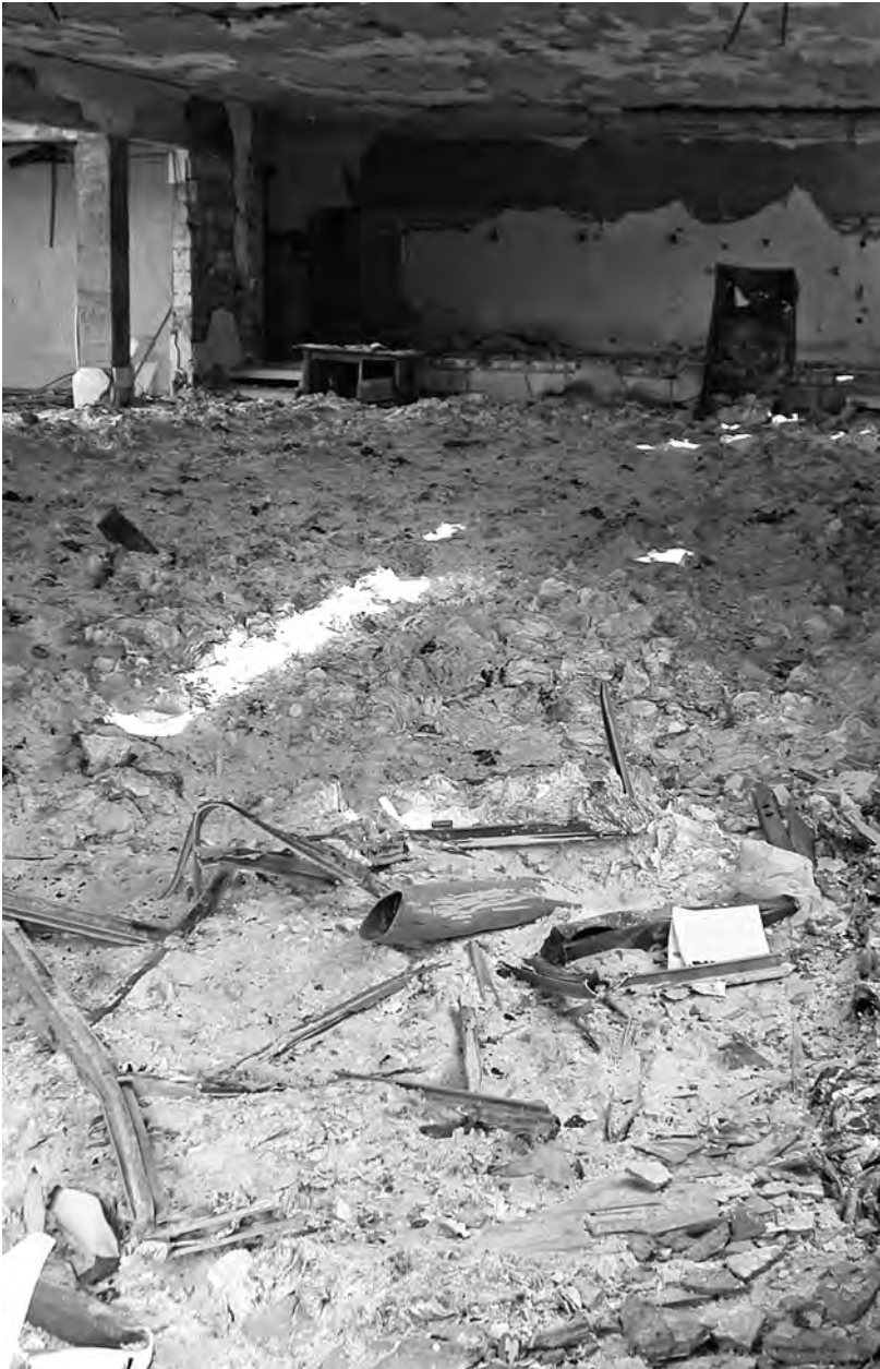
Abb. 4: Basra, im April 2003 vollständig ausgebrannter Raum der Stadtbibliothek. Photographie M. van Ess/UNESCO vom 1. Juli 2003.
