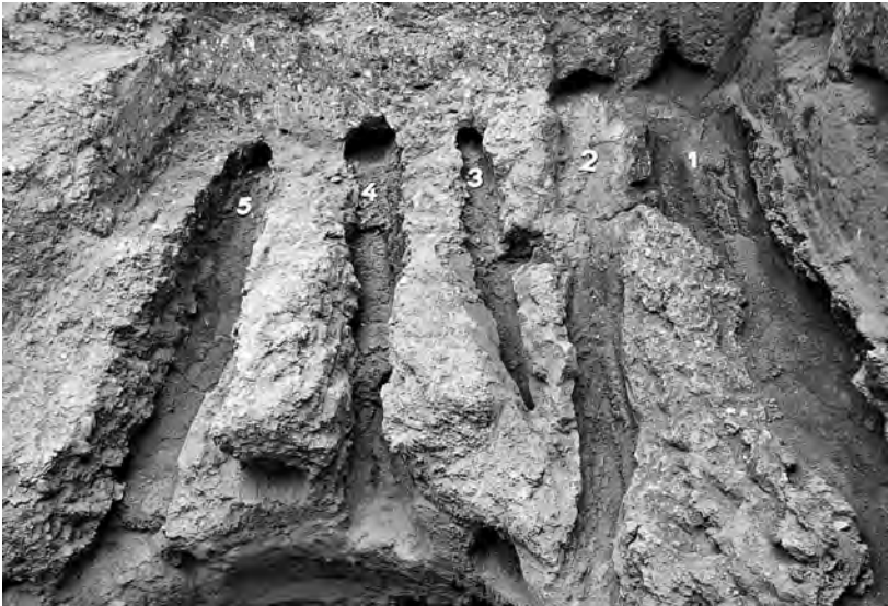
Abb. 12: Raum EP, Balkendecke in Art eines Parallelrosts unter dem Fußboden des Hanggeschosses.
