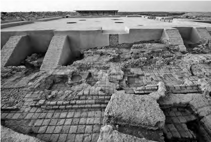
Abb. 26: Südmauer des Königspalastes, vorne der vorgezogene Risalit; im Hintergrund die restaurierte Halle C; Blick von Süd.
