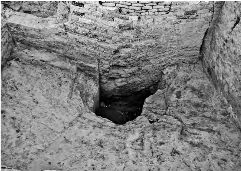
Abb. 4: Raum DA mit dem abschüssigen Lehmfußboden und der eingebrochenen Decke über dem Raum FK; von Ost.
