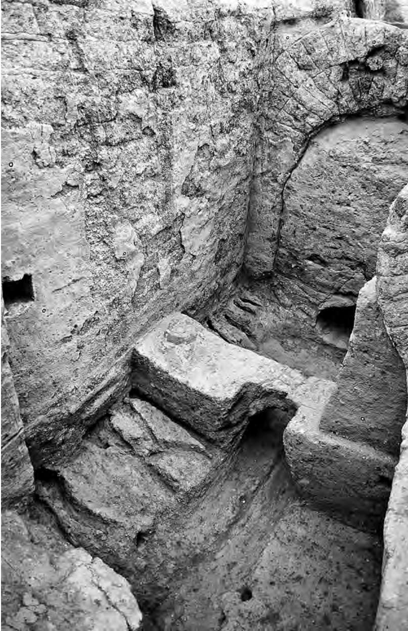
Abb. 3: Raum DC, Abdrücke von Querbalken und der Hauptträger der Deckenkonstruktion zwischen Hanggeschoss und Untergeschoss.
