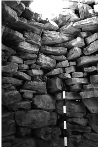
Abb. 28: Innenseite der Grabmauer Inst. 0010 (Foto: C. Schmidt).
