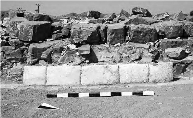
Abb. 2: Grab 155 von Osten mit fünf weißen Kalksteinen der ehemaligen Außenfassade (Foto: C. Schmidt).
