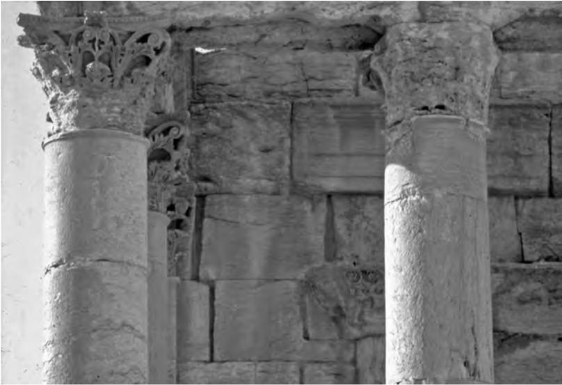
Abb. 32: Palmyra, Baalshaminempel, Säulen der Vorhalle, sowohl vertikal gebrochene Trommeln als auch horizontal gebrochene Schäfte (130/131 n. Chr.)
