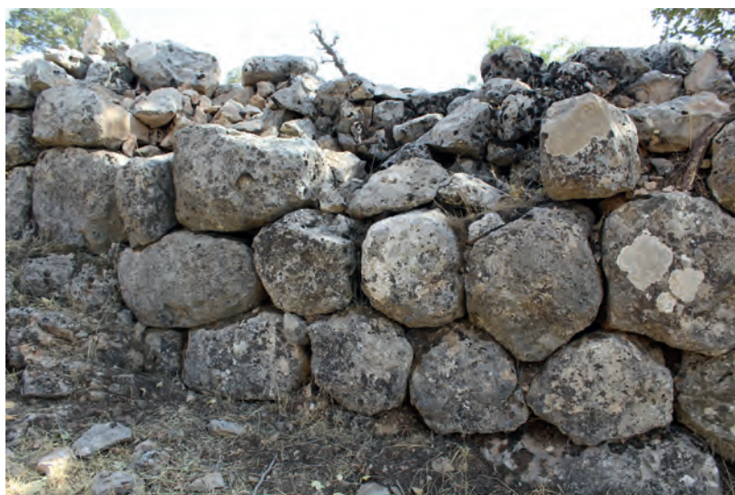
Abb. 6 a-b Hsarok KH 73: Gut 1 m hoch erhaltene Mauerabschnitte im Nordwesten, Ansicht von Nordwest.
