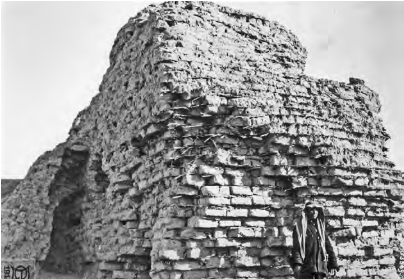
Abb. 2: Bab 3569, 6.11.1914: Babil, Querschnittsansicht derselben Mauer . Gemeint ist eine Aufnahme desselben Ortes aus anderer Perspektive. Das vorhergehende Foto hat jedoch eine schlechte Qualität. Beachtlich sind die enorme Mauerstärke und die erhaltene Höhe sowie die Zwischenlagen aus Schilfmatten in (fast) jeder Fuge.
