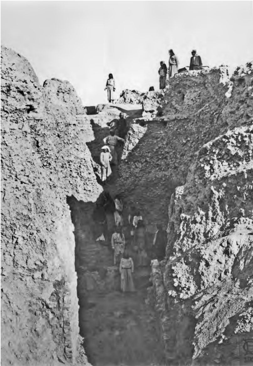
Abb. 3: Bab 3570, 6.9.1914: Babil, SW=Ecke des West=Hofes und Süd=mauer desselben
